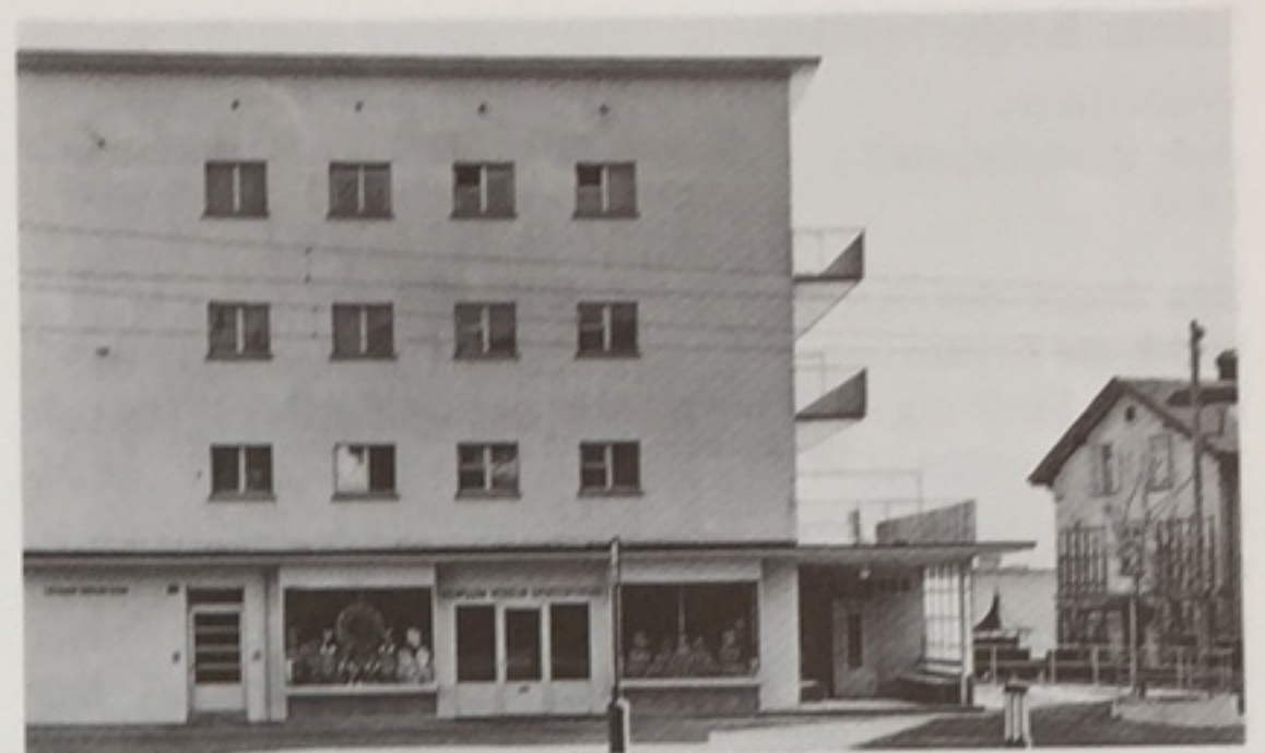
4 Kopfbau an der Frauenfelder-Strasse / Immeuble de tête
