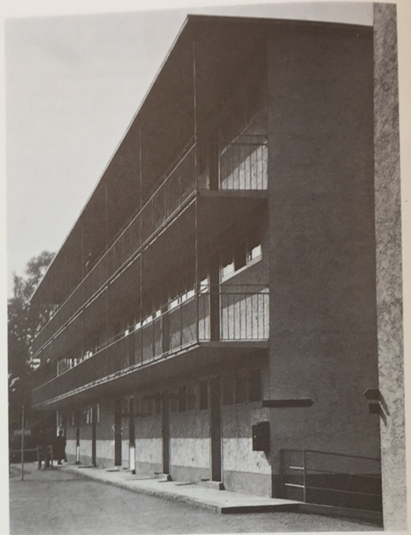
1 Laubenganghaus an der WOBA / Maison à coursives extérieures
